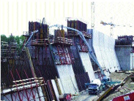
Betonieren der Kammerwände
